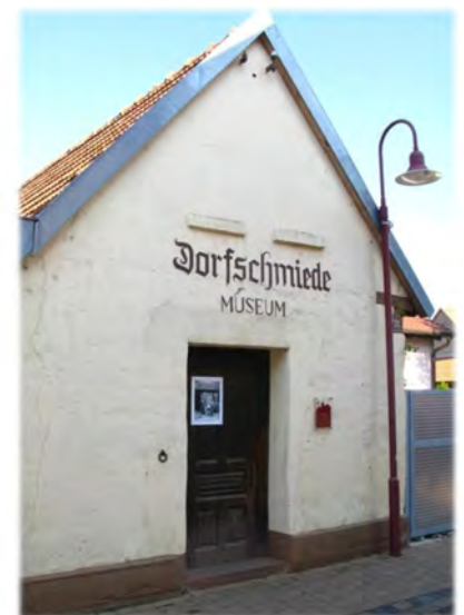
Historisches Gebäude: Dorfschmiede mit Hinweistafel
